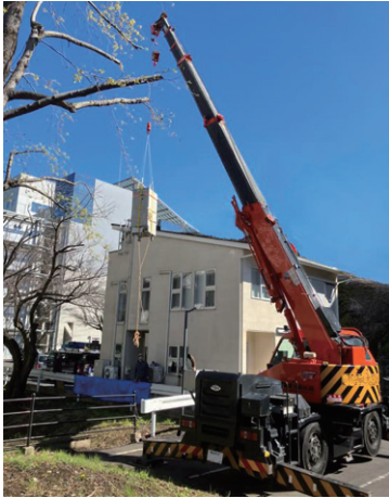
(b) HP 給湯機の設置 (2024年 3月)
