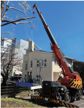
(b) HP 給湯機の設置 (2024年 3月)
